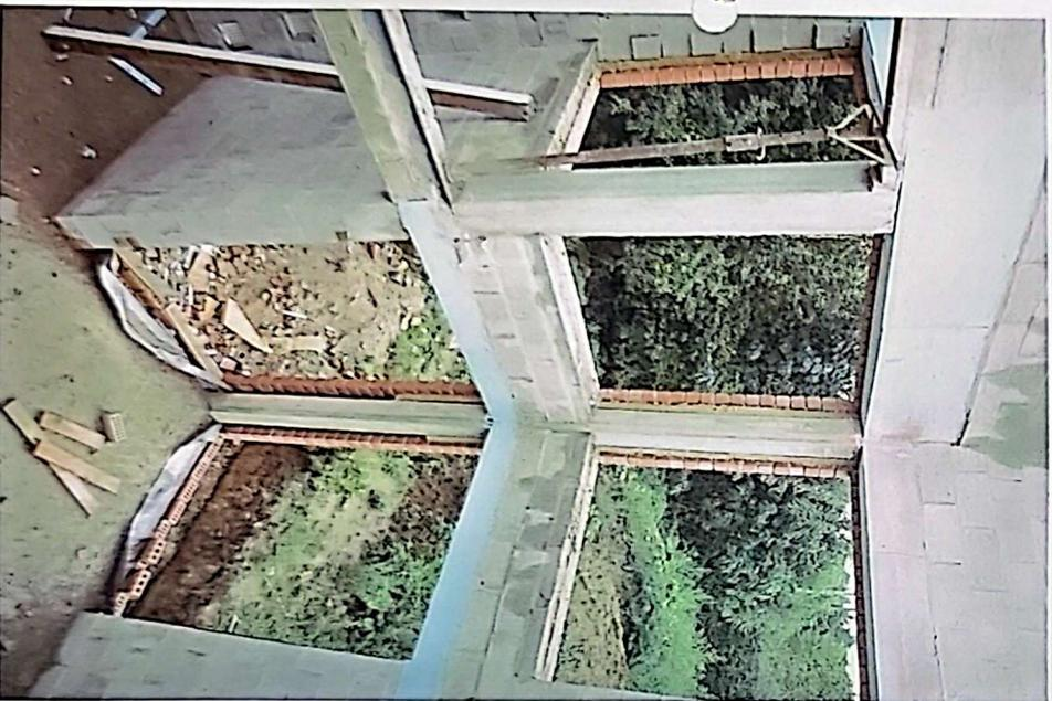
Fig.32. Vision intérieure au droit de l'ouverture de la mezzanine dont la structure au sol est à réaliser en bois.
