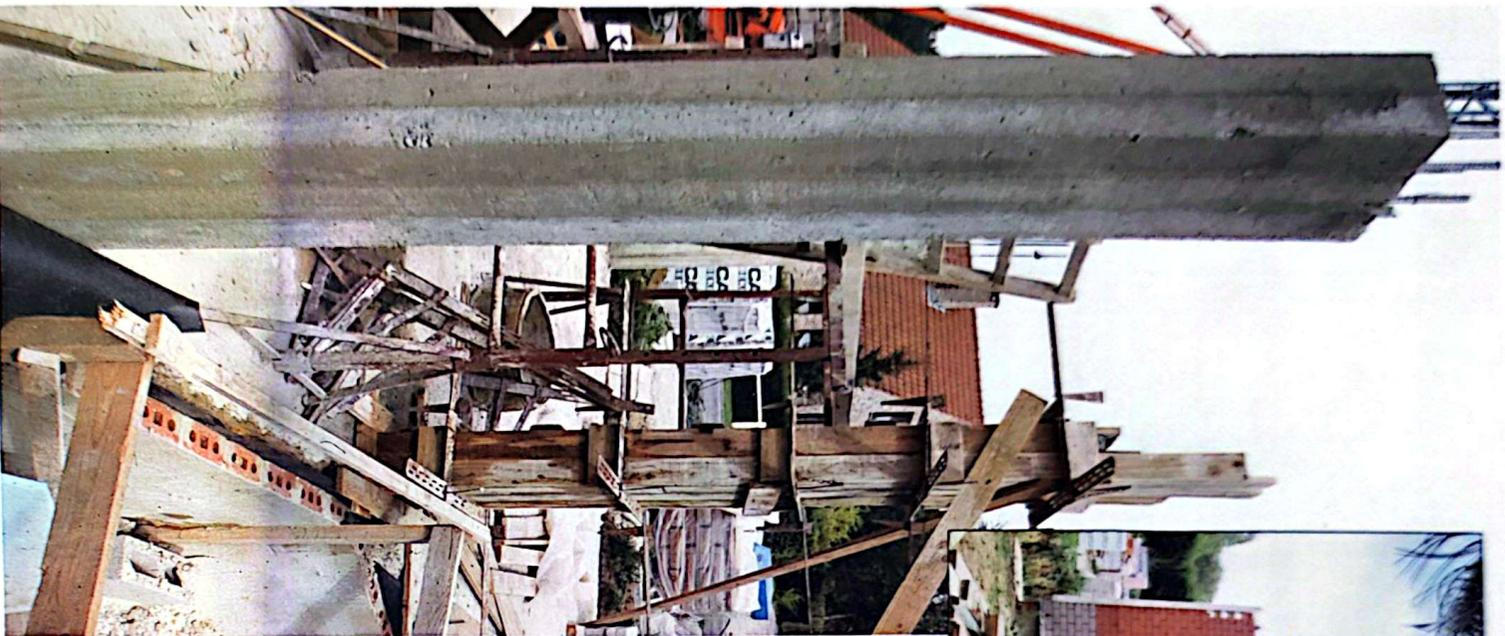
Fig. 25. Coffrage et décoffrage de la structure portante interne, sous forme de colonnes rectangulaires en béton, un travail qui nécessite son décali de mise en œuvre.
