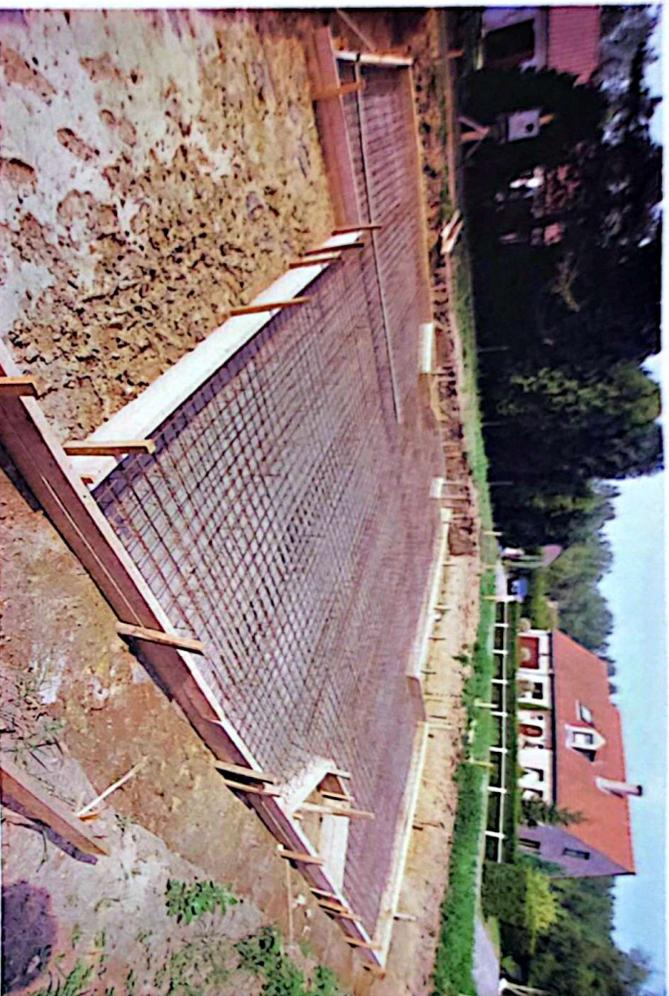
Fig. 16. L'étendue du radier dans sa fouille de fondation et sur toute la surface de la maison.
