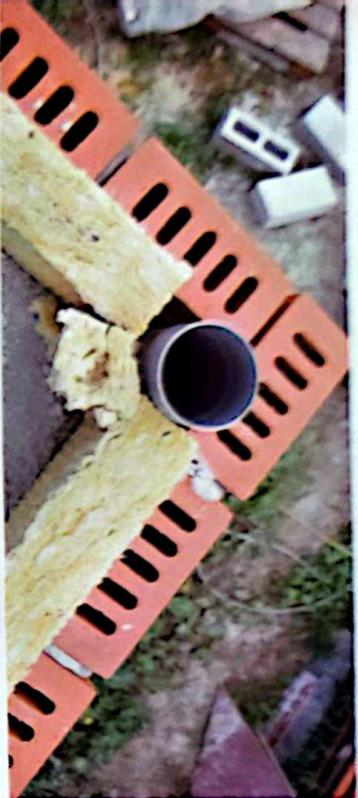
Fig. 34. Vue en cours des travaux de l'incorporation des descentes d'eau pluviale en PVC collé, dans l'angle des maçonneries de façades. Un travail à exécuter avec précision et précaution.
