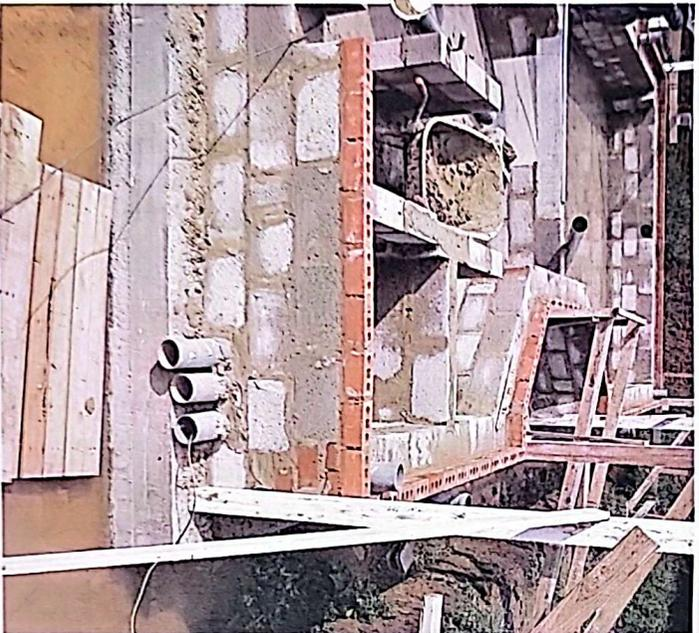
Fig. 19. Les maçonneries sont à hauteur de pose des hourdis du rez et toutes les canalisations intégrées au vide ventilé sont en attente sur le réseau extérieur.
