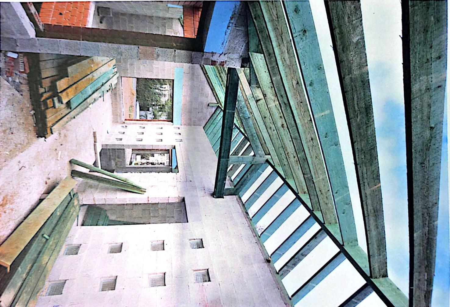
Fig 33 La pose de la charpente vient proportionner très précisément les volumes des chambres sous toiture. A remarquer les pavés de verre au droit de la salle de bains et de l'escalier.
