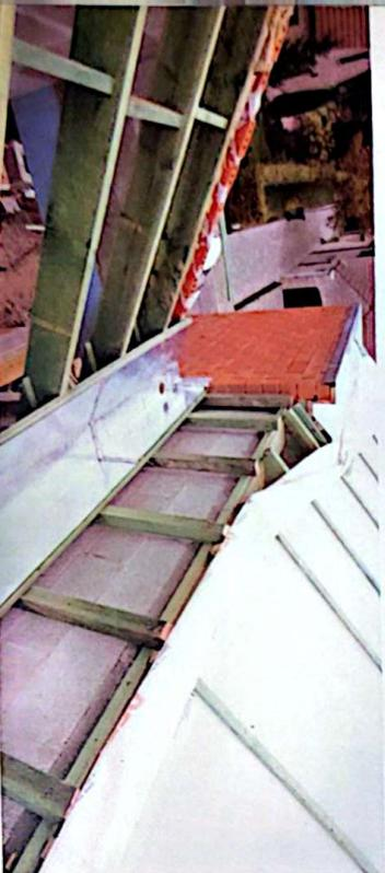
Fig. 36. Chêneau entre les deux entités de toiture. Une exécution réclamant toute la vigilance pour solutionner les problèmes de différents types de raccords. C'est dans les détails que se font les véritables étanchéités de toiture !
