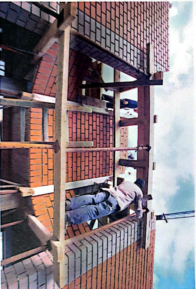
Fig. 15. Préparation des coffrages de la poutre portique sur les deux façades latérales. Tout un travail d'étaiement pour soutenir le coffrage en briques de parement.
