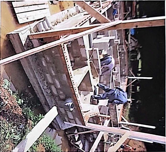
Fig. 18. Sur cette assise, c'est le départ de tous les murs porteurs de la structure de la maison, avant pose des hourdis du rez.
