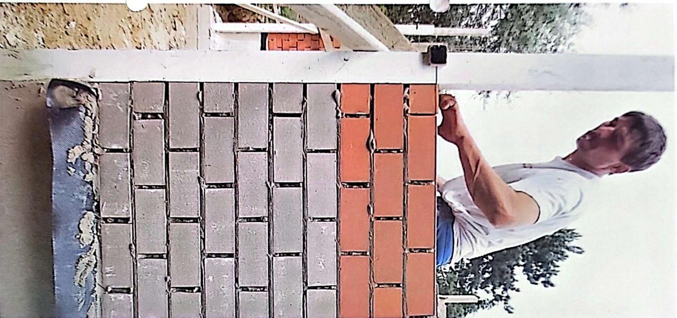
*Fig 21. La précision de la maçonnerie de parement apporte les premières références à la maison véritablement finie. A remarquer la membrane de rejet vers l'extérieur des eaux de ruissellement à l'intérieur de la coulisse du mur creux.*
