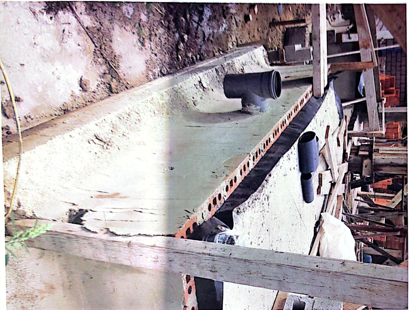
Fig.20 Nous pouvons constater le soin du cimentage hydrofuge en arrondi au pied des fondations, les membranes d'étanchéité contre les remontées d'humidité ascensionnelle et la pièce PVC en T servant à la ventilation du vide sanitaire
